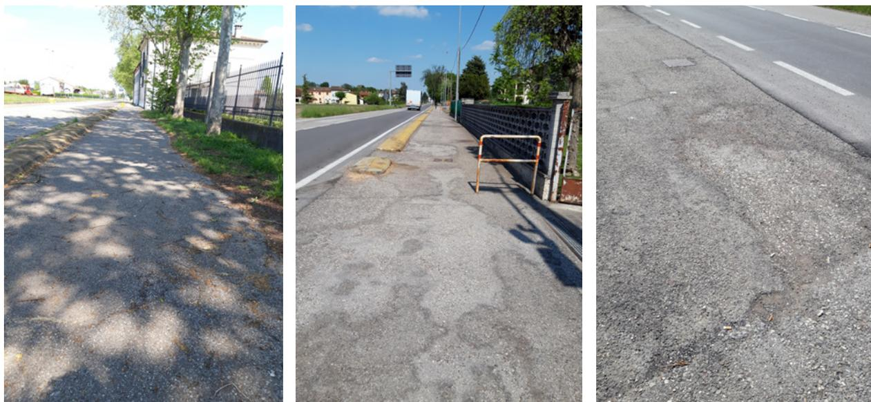
Descrizione prestazionale possibile intervento: Rifacimento del marciapiede o percorso pedonale esistente previa demolizione della pavimentazione compreso il sottofondo. Il nuovo piano di calpestio dovrà risultare compatto, omogeneo con pendenza trasversale non superiore all'1%.
