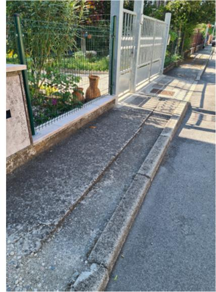
Descrizione prestazionale possibile intervento: Rifacimento del marciapiede o percorso pedonale esistente previa demolizione della pavimentazione compreso il sottofondo. Il nuovo piano di calpestio dovrà risultare compatto, omogeneo con pendenza trasversale non superiore all'1%.
