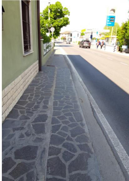
Descrizione prestazionale possibile intervento: Rifacimento del marciapiede o percorso pedonale esistente previa demolizione della pavimentazione compreso il sottofondo. Il nuovo piano di calpestio dovrà risultare compatto, omogeneo con pendenza trasversale non superiore all'1%.
